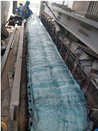
Bei hohen Temperaturen sind passgenaue Isolierpackungen für den Kompensator unerlässlich, da sie die Anwendungstemperatur absenken. *Bild: © Frenzelit GmbH*
