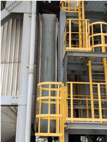
Bereit für hohe Temperaturen, Bewegungen und Ausdehnungen: der ausgetauschte Gewebekompensator mit Isolierlagen aus Hochtemperaturfasern von Frenzelit. *Bild: © Frenzelit GmbH*
