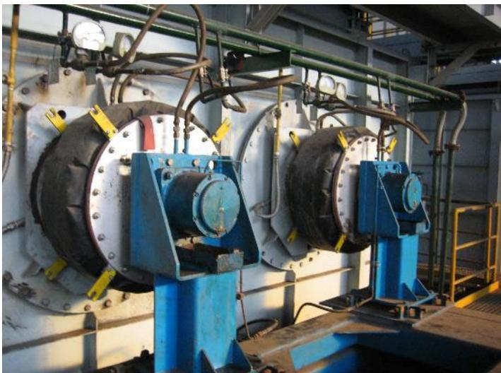
Gewebekompensatoren gleichen die Bewegungen der Steuerrollen aus, die die Blechbänder zentrisch durch den Ofen lenken sollen. *Bild: ©Frenzelit GmbH*
