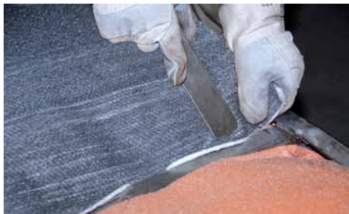
Maß- und Handarbeit: Einbau des BBM-Compounds.
